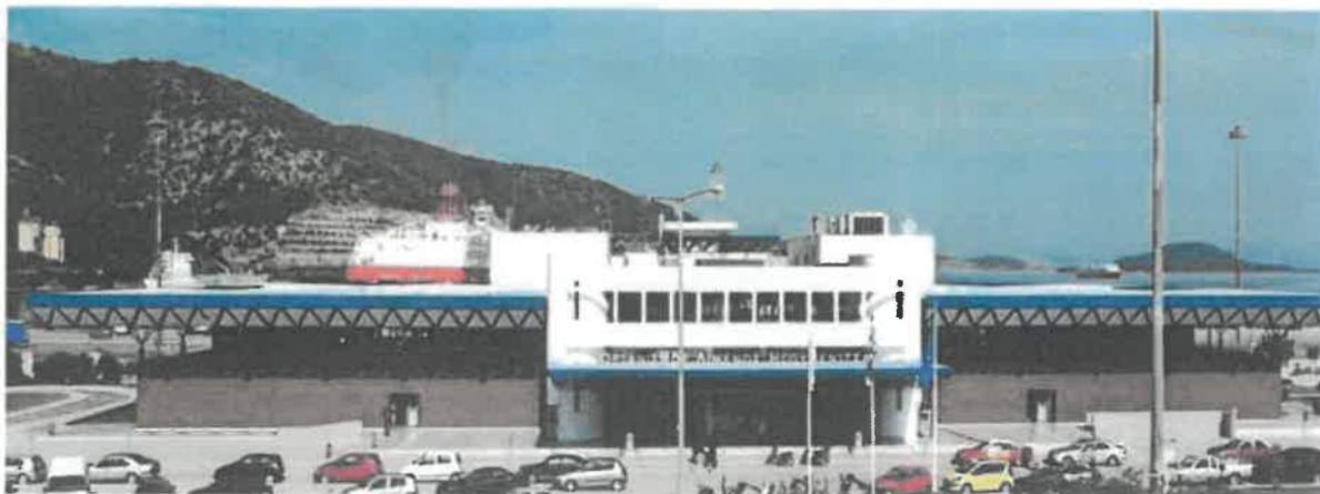
Εικόνα 2: Τερματικός Επιβατικός Σταθμός T1
