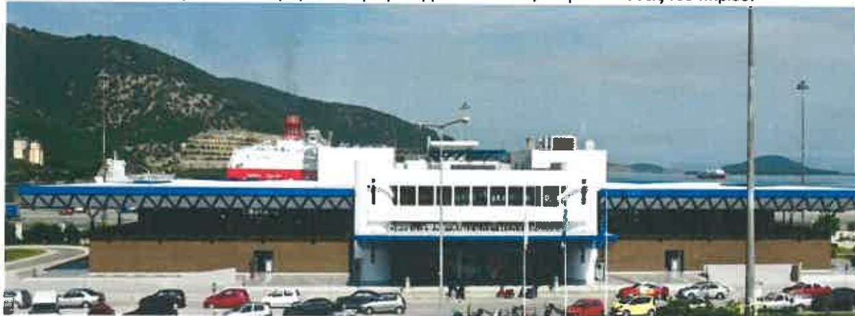
Εικόνα 1: Τερματικός Επιβατικός Σταθμός T1
