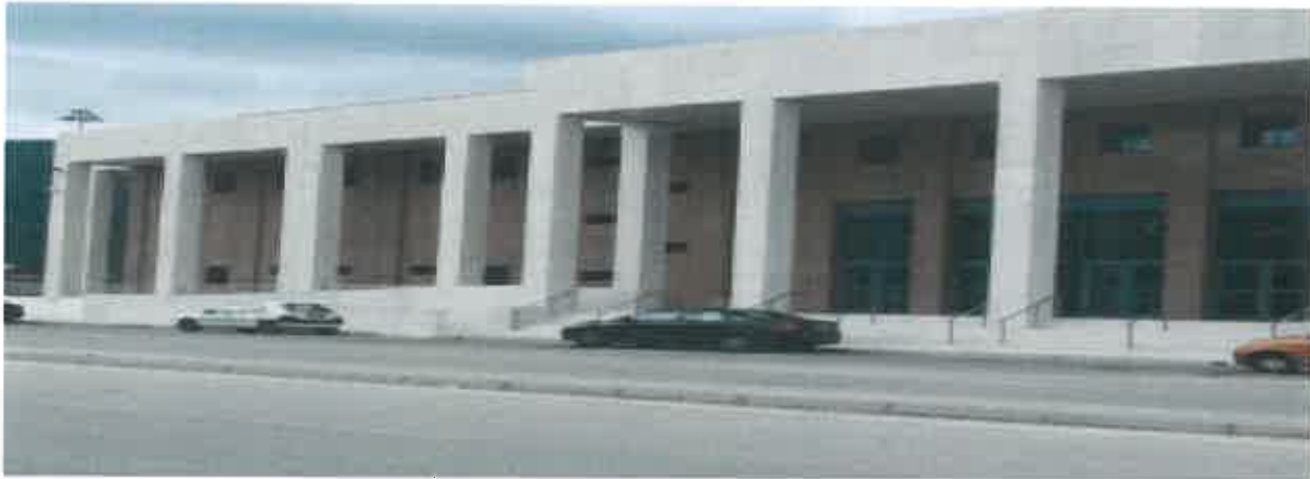
Εικόνα 2: Τερματικός Επιβατικός Σταθμός T2
